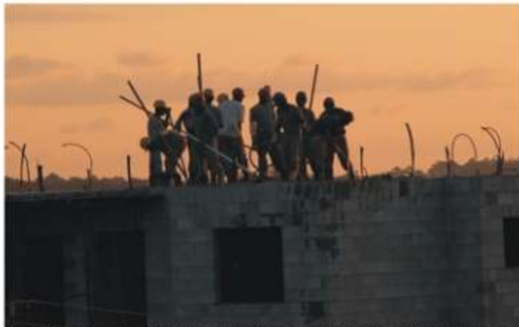
Trabalhadores da construção civil na formação de laje em edifício. Fim de tarde dá o contraste à cena
